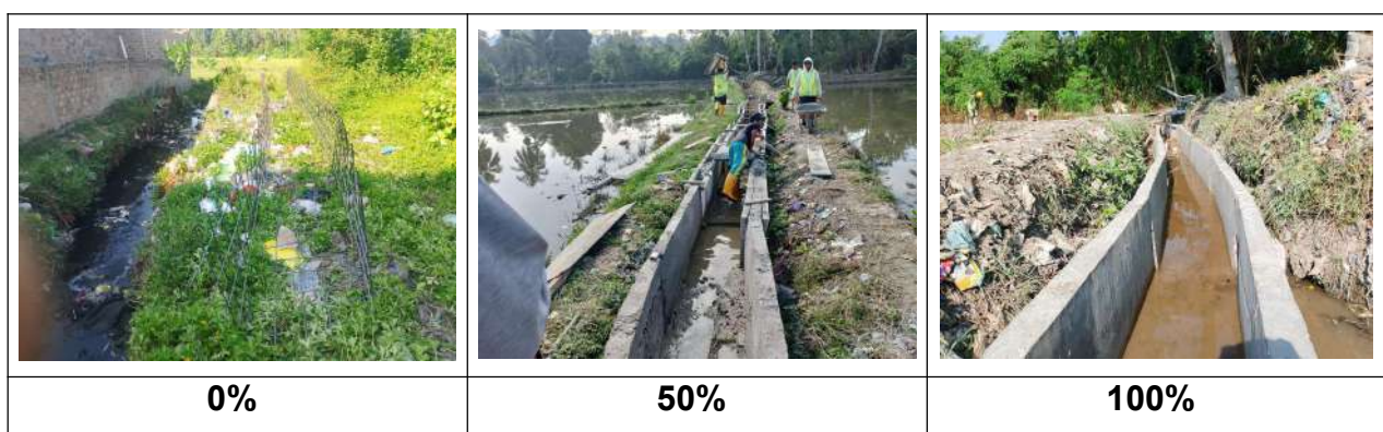
Gambar 3.4 Foto Kegiatan Pembangunan Drainase Kota Muara Dua Kab. Oku Selatan
